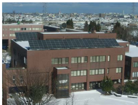
附属図書館屋上 (太陽光発電35kw)
