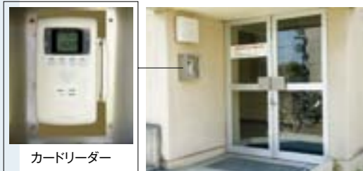
建物玄関 防犯用に「カードロックシステム」を導入しています。
